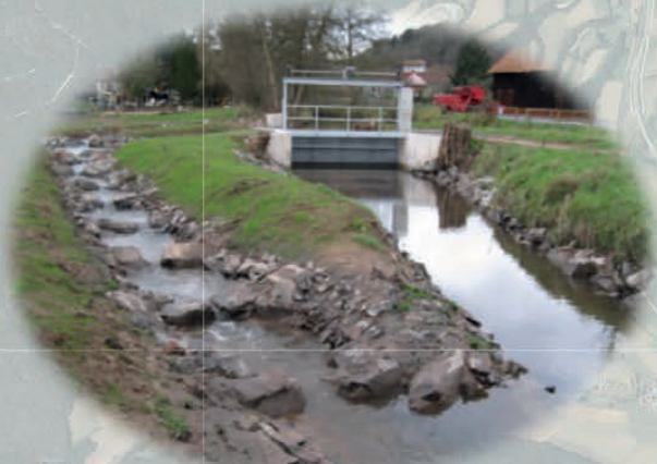
② Fischtreppe an der „Aulamühle“ kurz nach der Fertigstellung
