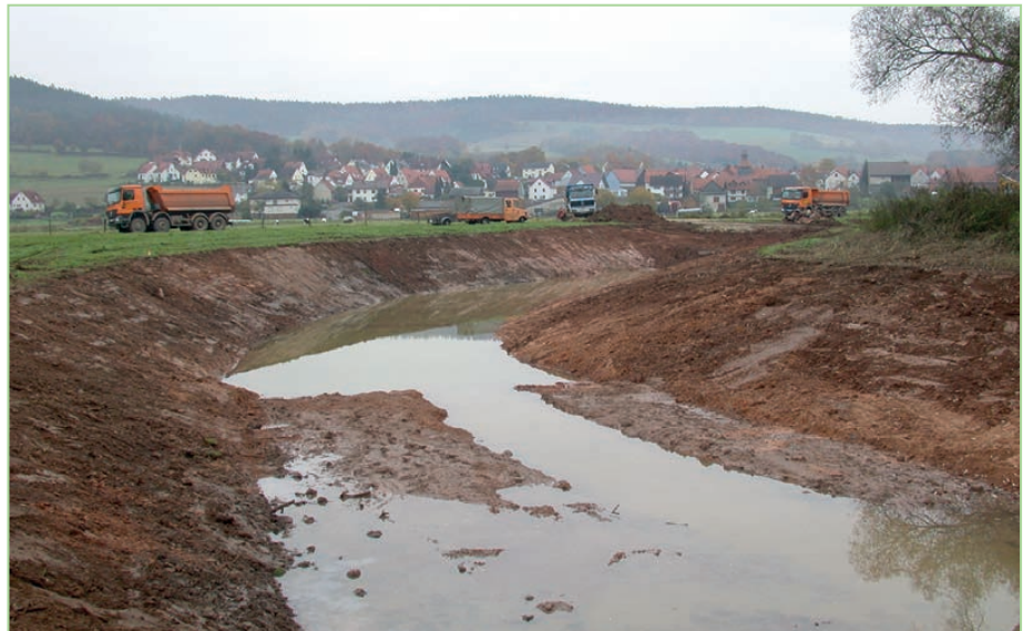
Die Hochflutrinne im Bau
