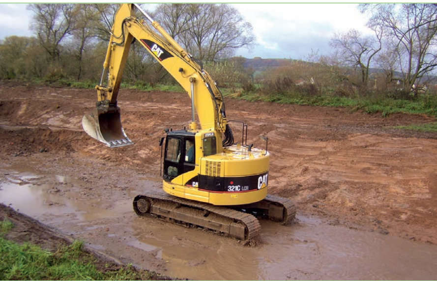
Der Bagger bei der Arbeit
