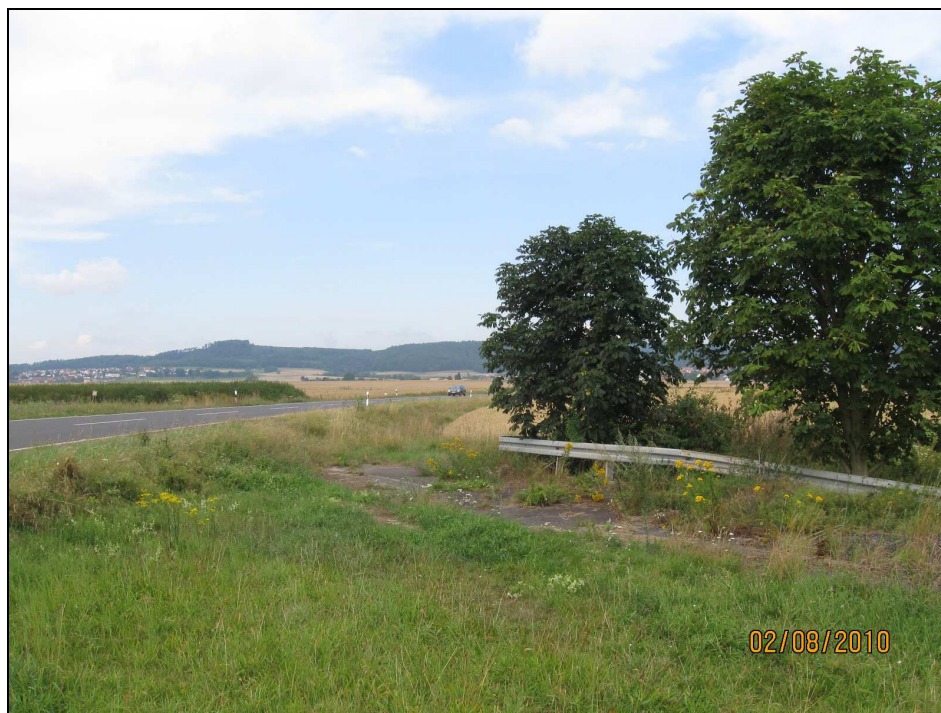
Bild 5: Neue Wegeverbindung Nr. 131.1/131.2 über die Brücke Nr. 501
