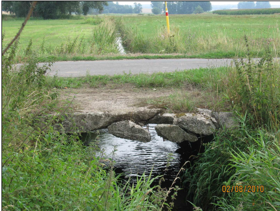
Bild 8: Brücke Nr. 502 über den Rülfbach
