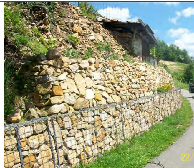
Entlang des Teilabschnitts Nr. 18.8 des Drosselbergweges und des Teilabschnitts Nr. 22.5 des 5-Minutenpfades werden zur Absicherung der Böschung, dort wo es erforderlich ist, neue Gabionenmauern errichtet. Es handelt sich um die Mauern Nr. 864.1; 864.2 und 864.3 am 5-Minutenpfad sowie um die Mauern Nr. 803.1; 803.2 und 803.3 am Wegeabschnitt Nr. 18.8 des Drosselbergweges. Die Beschreibung der Mauern und die Pläne sind in der Beilage 6 enthalten.
