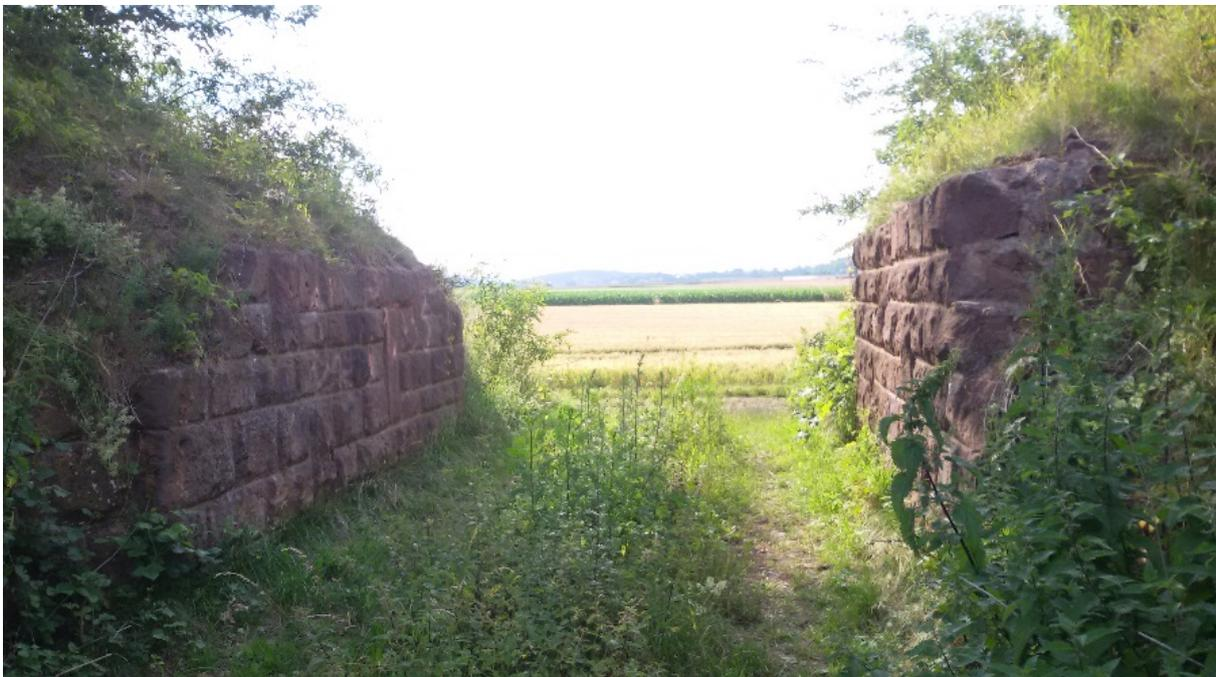
Blick auf die ehemalige Brücke in der Wohratalbahn Nr. 504. Die Widerlagerwand auf der rechten Bildseite soll abgerissen und die Sandsteine als Trockenmauer 3,5 m weiter rechts wieder neu aufgeschichtet werden.
