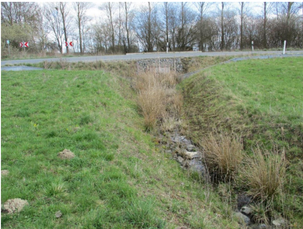
Abb. 25: Aufnahmedatum vom 07.04.2016, vorhandener Gewässerausbau der Straßenbauverwaltung
