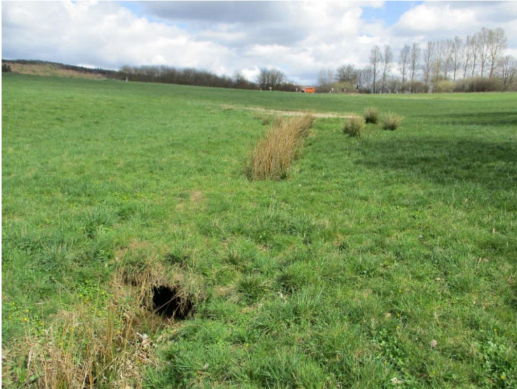
Abb. 26: Aufnahmedatum vom 07.04.2016, vorh. Durchlass DN 300, mit Blickrichtung gegen die Fließrichtung
