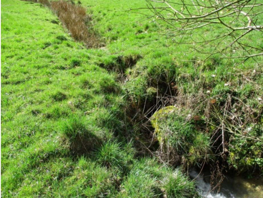
Abb. 28: vom 07.04.2016, vorh. Durchlass DN 400, mit Blickrichtung gegen die Fließrichtung
