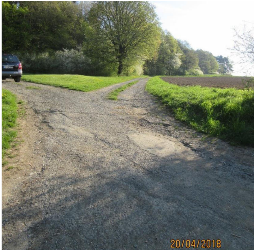
Abb. 18 Weg Nr. 7.1, von Weg 6 in nördliche Richtung blickend
