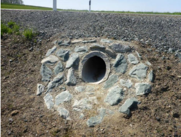
Abb. 24: vorh. Durchlass Straße Nr. 2, Aufnahme datum vom 23.04.2015
