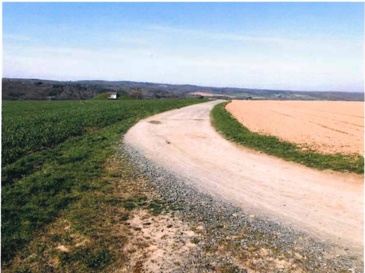
Abb. 3: Weg 27, Blickrichtung nach Westen zum Hochbehälter Brandoberndorf
