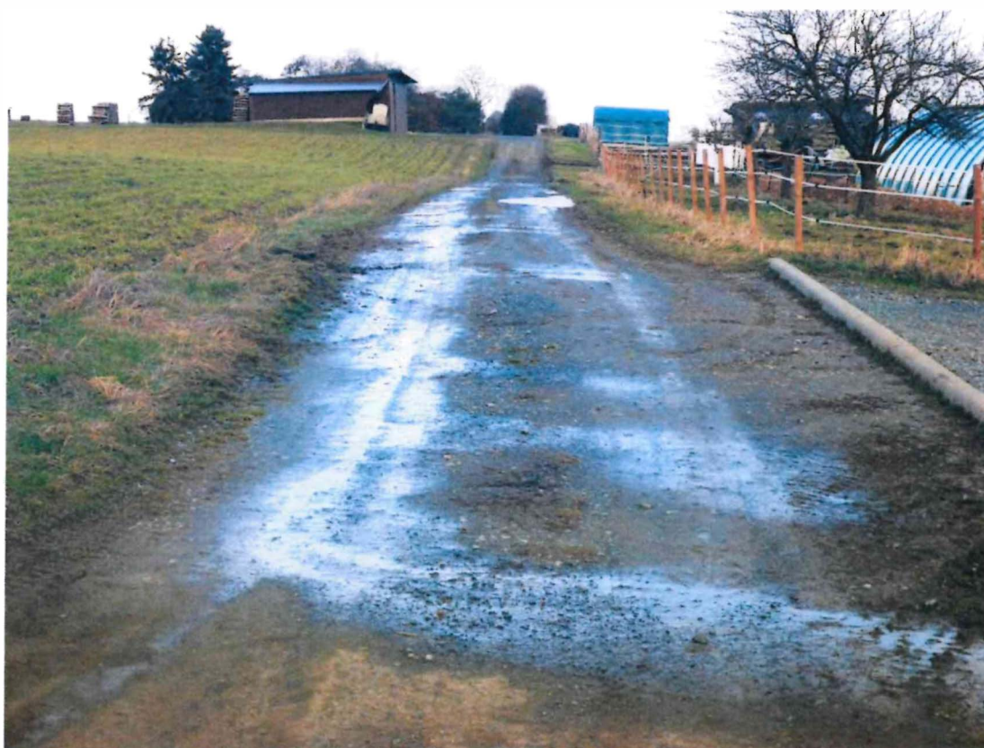
Abb. 7: Weg 112, Blickrichtung nach Osten
