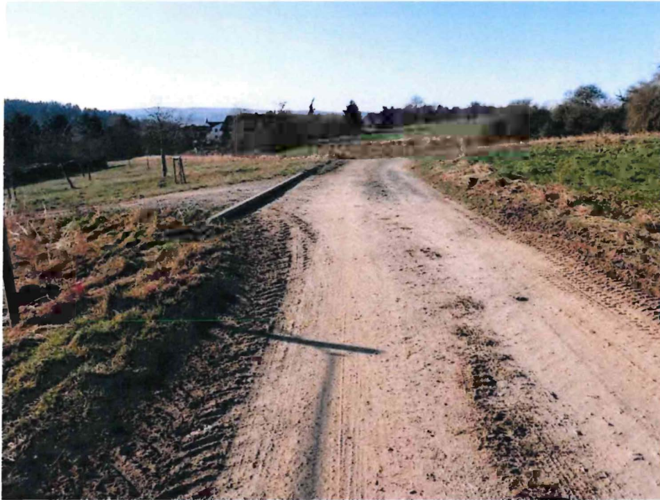
Abb. 4: Weg 112, Blickrichtung nach Westen in Richtung der L3055
