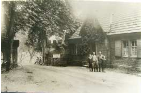
ehem. Kailbacher Tor
