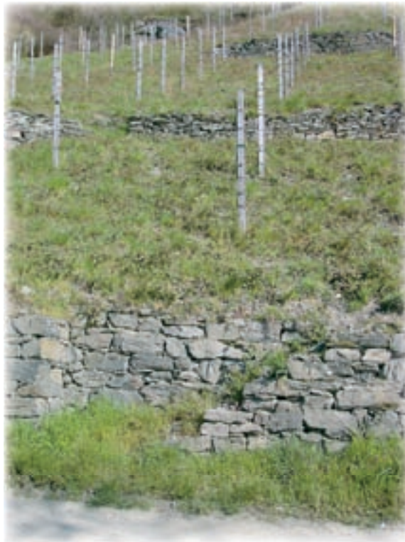
Trockenmauern am Terrassenweinberg
